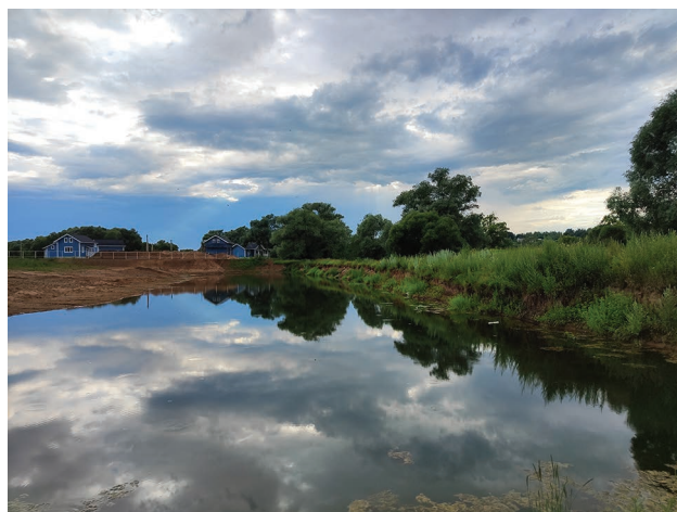
Общий вид котлована.
