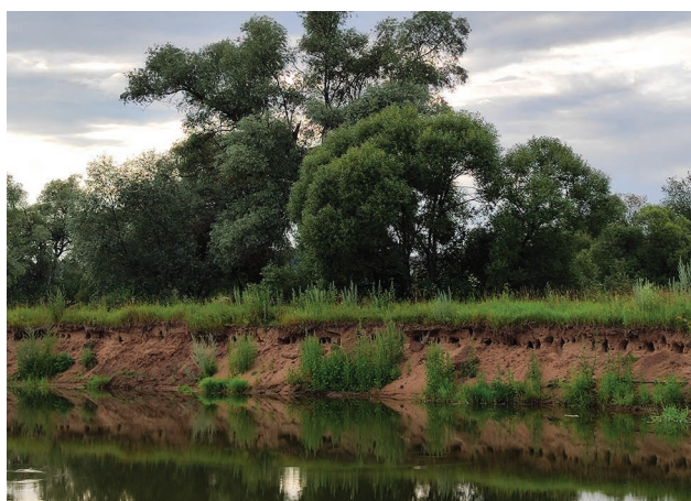
Стенка котлована с норками.
