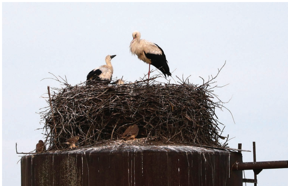
Фото 2. Гнёзда белого аиста и пустельги на водонапорной башне в Пушкино, Можайский м.о., 7.07.2025 г. Фото: К.Ю. Шамина
